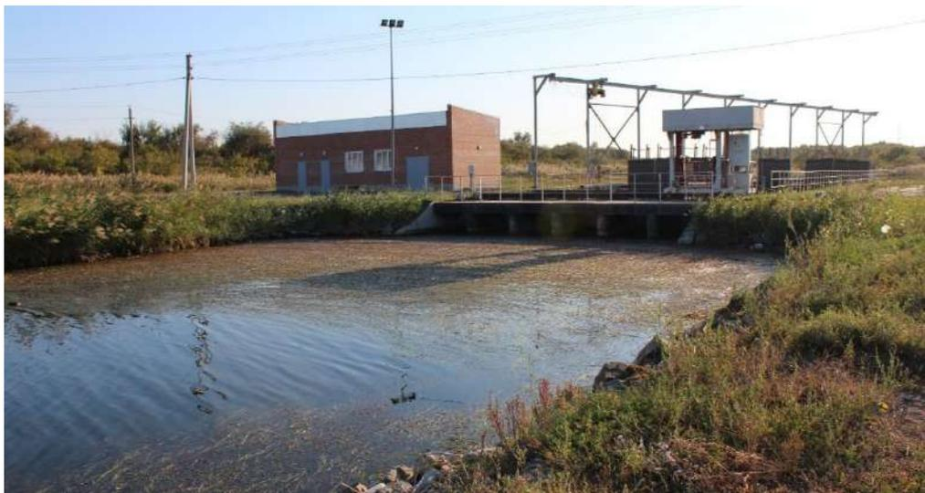
**Рисунок 1.** Заращение и накопление водорослей в подводящем канале РЗС.
